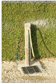
Cimetière II : fin des travaux d'accessibilité handicapés et pose de points d'eau supplémentaires
