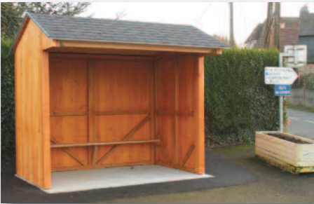
Confection de plateformes pour la pose d'Abribus au Gage et rue du Vieux Lavoir.
