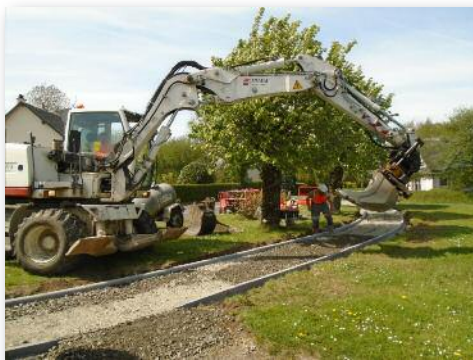
Rue des Bruyères : réfection du cheminement piétonnier
