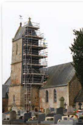
Réfection du bardage du clocher
