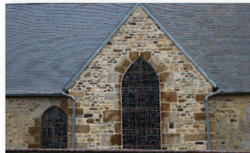
Réfection des joints sur la chapelle sud de l'église
