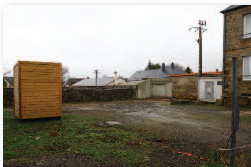
Arrière de la mairie : destruction des anciennes installations techniques pour la création d'un parking et toilettes accessibles aux Personnes à Mobilité Réduite
