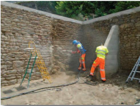
*Intersection rue Trainerie chemin de la Blanchisserie : sablage du mur par les employés communaux et réfection des joints.*
