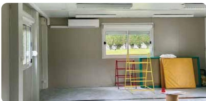
Changement du système de chauffage dans l'extension de l'école et passage en pompe à chaleur air/air
