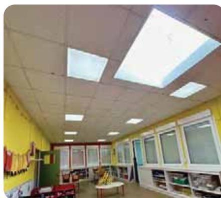
Changement du système d'éclairage de l'école avec passage aux LEDS et à un système automatisé
